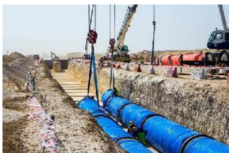
Слика 1. Полагање цеви на главном коридору
