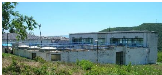
Slika 1. PPV „Bresje“, postojeće stanje: napred: otvoreni flokulatori, taložnici i filteri; u pozadini: filterska galerija (desno), upravno-servisni blok (sredina), magacin hemikalija (levo)
