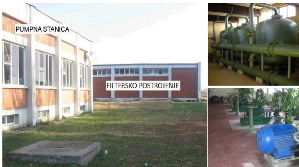
Слика 1. Постојеће зграде филтерског постројења и пумпне станице
