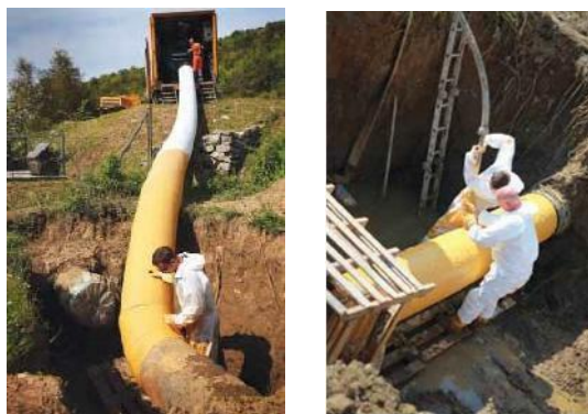
Slika 2. Priprema i uvlačenje sanacionog materijala dionica PK Prijevor – PK Tivat
