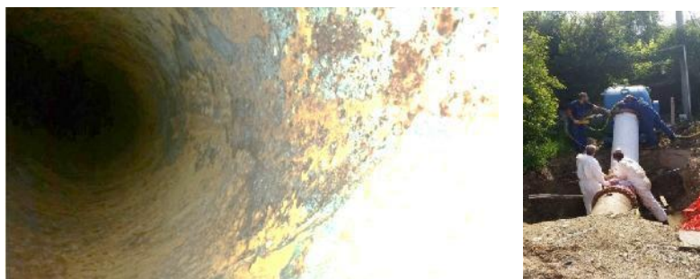
Slika 3. PK Tivat – PS Podkuk – unutrašnjost cijevi - uvlačenje sanacionog materijala
