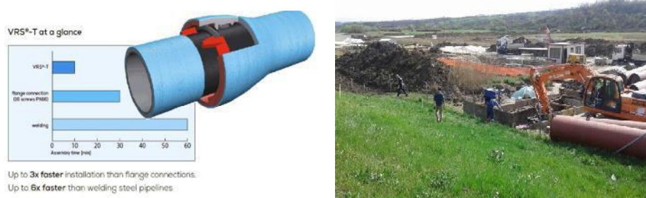
Слика 2. Поглед на градилиште (лево) и предности током монтаже дуктилних цеви (десно)
