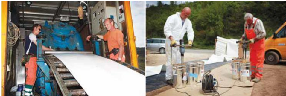
Slika 1. Priprema sanacionog materijala - SANFLEX
