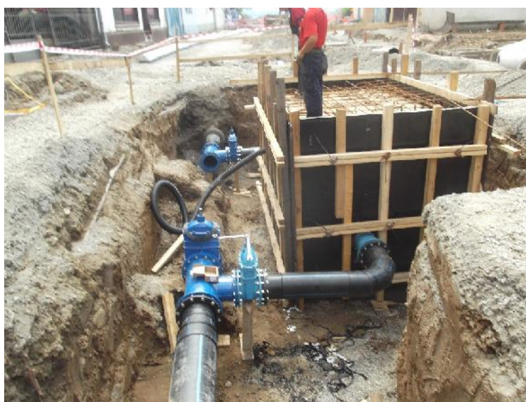
Слика 6. Израда дефинисаних мерно-регулационих места
