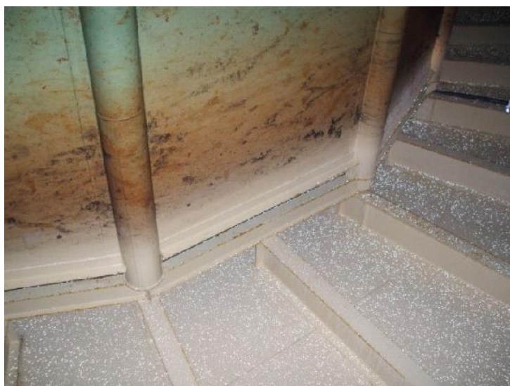
Slika 4. Unutrašnji izgled rezervoara
