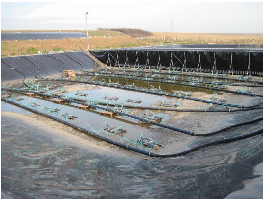
Slika 1. Montaža aeracionog sistema na novoj deponiji "Dolovo"
