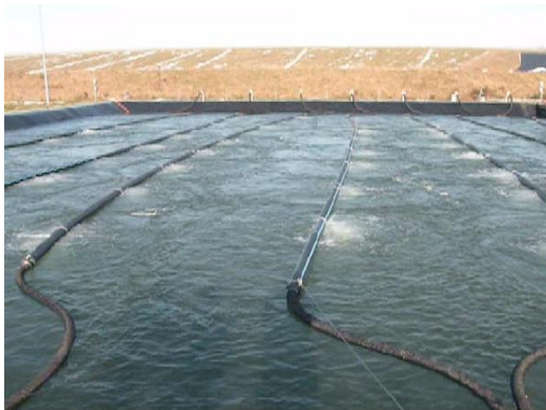
Slika 2. Rad aeracione lagune po sistemu WAVE OXYDATION na deponiji «Dolovo»
